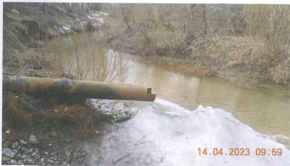
Рисунок 14 – В период работ зафиксированы сбросы с отстойника «Заказчика» с расходом 10 л/с
