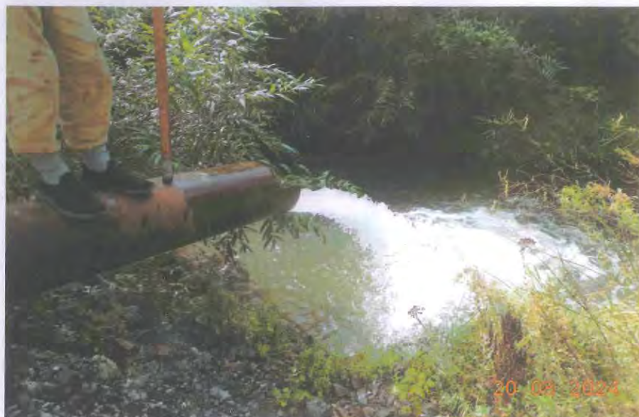
Рисунок 9 – В период работ зафиксированы сбросы с отстойника «Заказчика» с расходом 45 л/с
