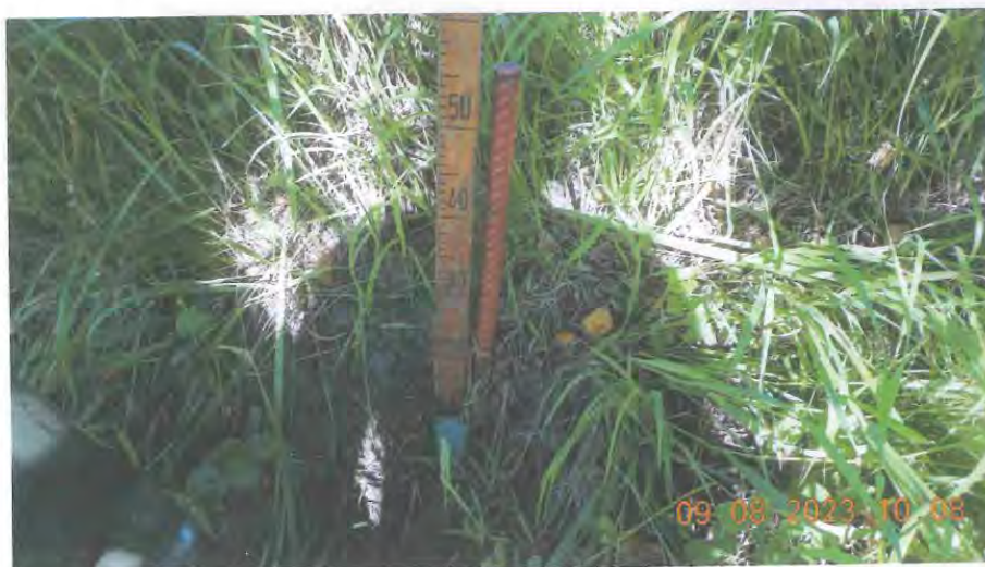
Рисунок 17 – Оголовок сваи над землей на 56 см
