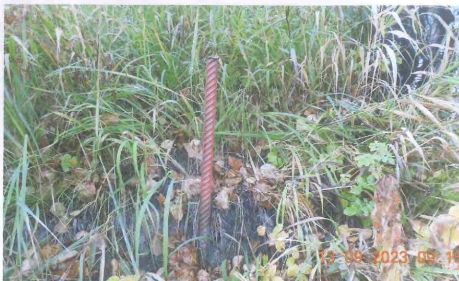
Рисунок 11 – Оголовок сваи над землей на высоте 56 см
