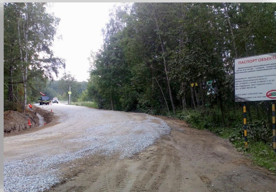
Строительные работы на автодороге п.Новый – с.Морозово
